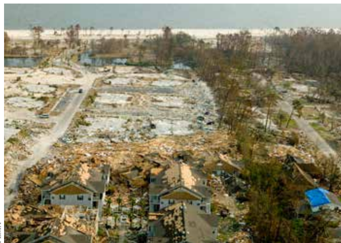
Una vista aérea de Gulfport, Misisipí, después del huracán Katrina que muestra casas sacadas por completo de sus bases y destruidas.
